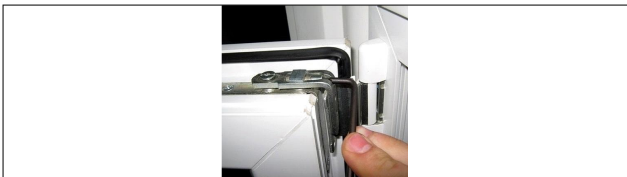
Рис. 14. Регулировка верхней петли – изменение положения створки по горизонтали.
