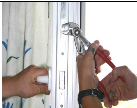
Рис. 10. Если цапфа не имеет паза, то для усиления прижима необходимо зажать её плоскогубцами и повернуть по часовой стрелке, а для ослабления – против.
