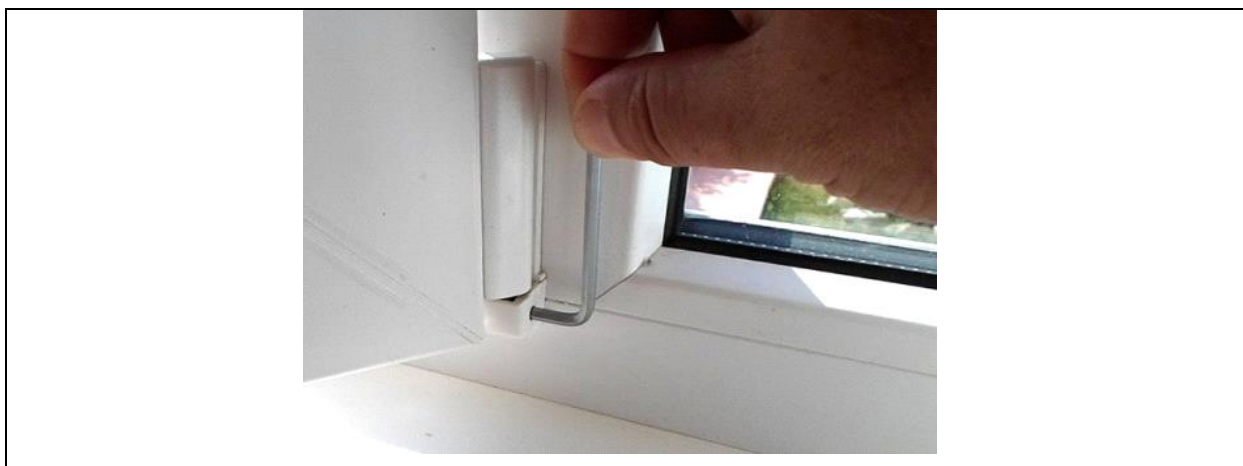
Рис. 12. Регулировка нижней петли – изменение положения створки по горизонтали.
