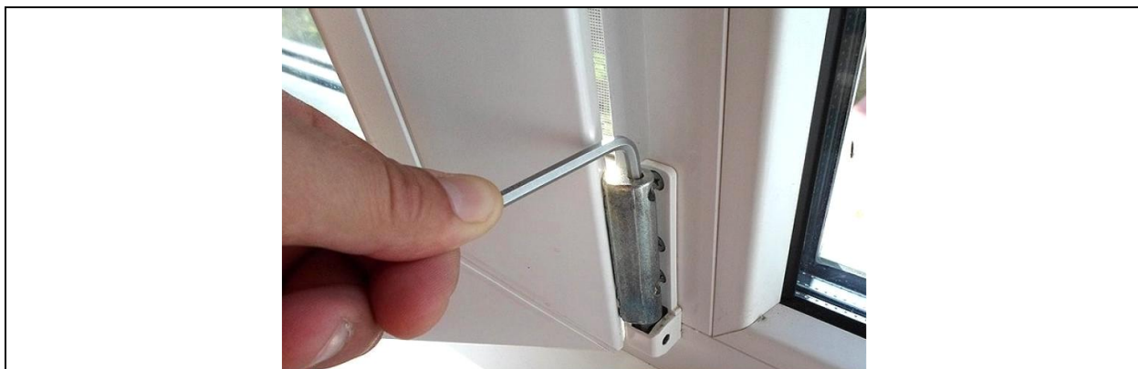
Рис. 11. Регулировка положения створки по вертикали.
