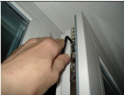
Рис. 9. Если цапфа с шестигранным пазом, то, для усиления прижима необходимо вставить шестигранный ключ в паз и повернуть по часовой стрелке. Ослабление осуществляется аналогичным образом против часовой стрелки.
