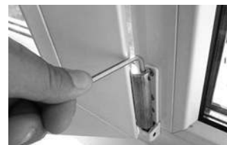
Рис. 7. Регулировка положения створки по вертикали
