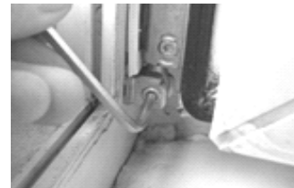
Рис. 9. Регулировка нижней петли при открытой створке.
